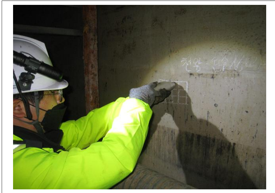
【그림 4.2.1】 비파괴 콘크리트 압축강도 측정 현황
